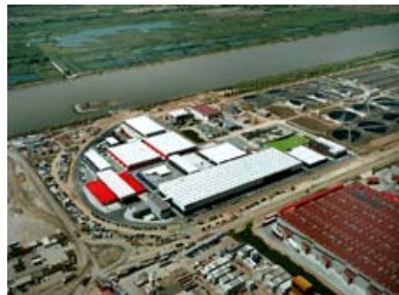
Dessalinitzadora del Llobregat Desalinizadora del Llobregat Llobregat desalination plant
