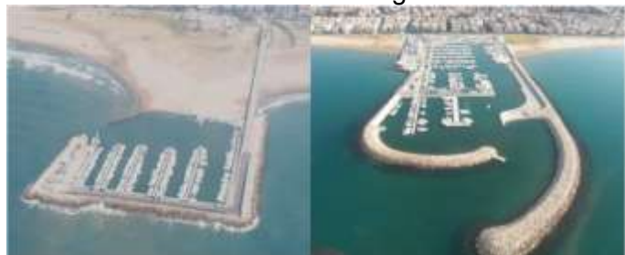
Remodelació del Port de Segur de Calafell
